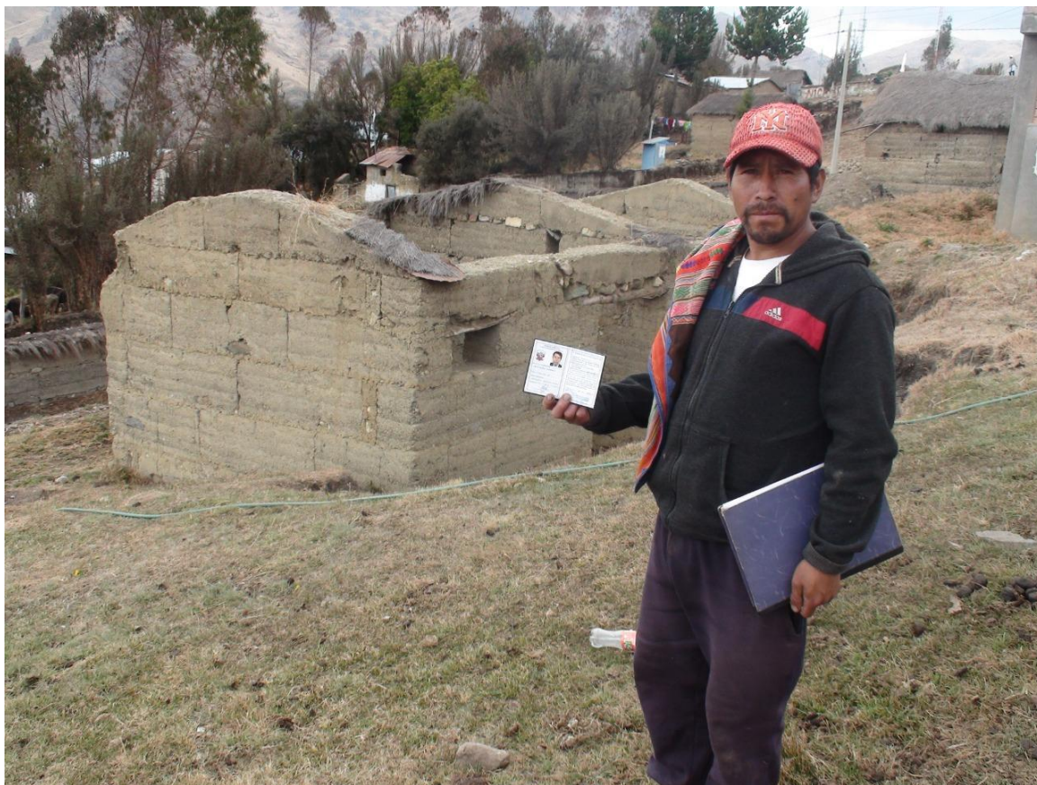
Fotografía 2: Local en construcción del Juez de Paz de Uchurraccay
