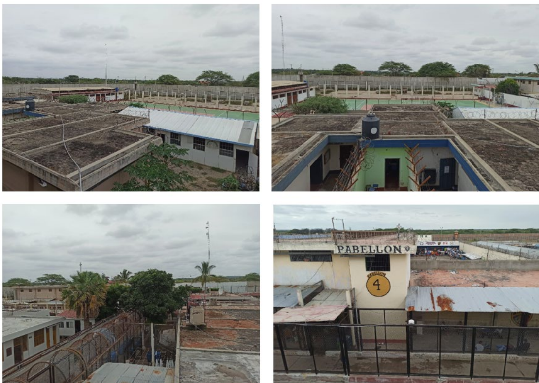
Figura. Infraestructura e instalaciones del E.P. de Ex Río Seco
