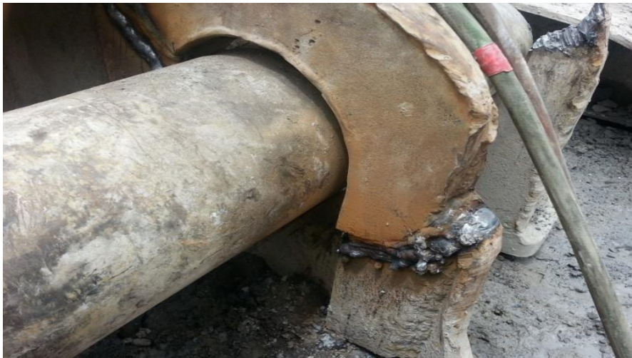
Figura 9. Inspección en Planta de Mina.
