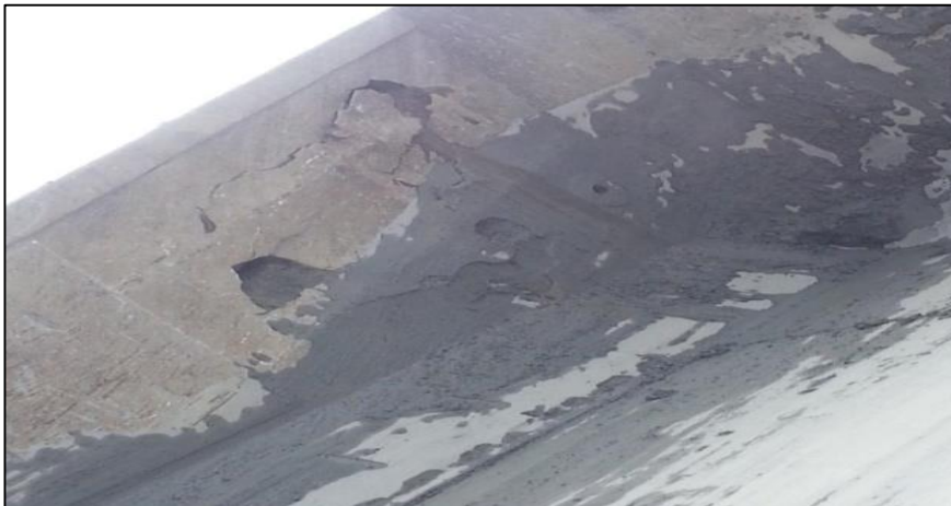
Figura 5. Plancha lateral interior RH con fisuras, desgastada y con partes de planchas desprendidas
