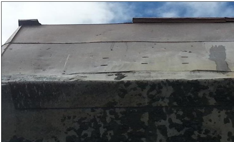
Figura 3. Inspección en Zona de Mina 2017
