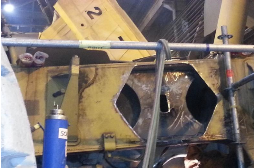
Figura 6. de Inspección en Planta de Mina.
