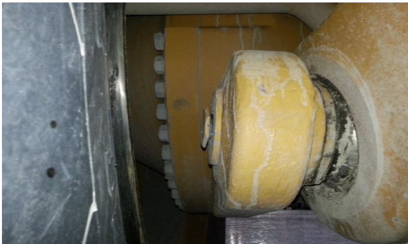
Figura 11. Inspección en Planta de Mina.
