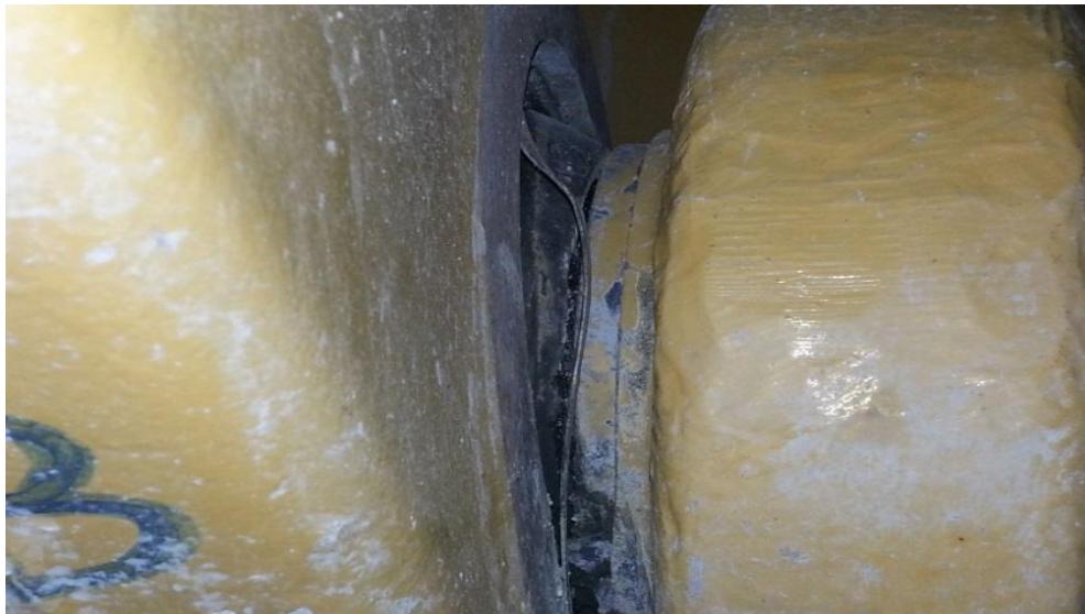
Figura 13. Inspección en Planta de Mina.
