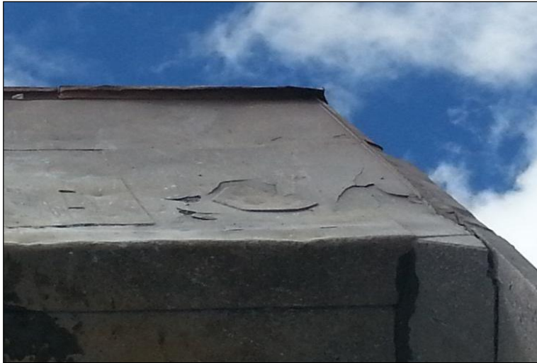
Figura 4. Inspección en Zona de Mina.
